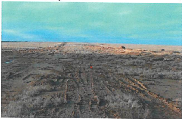
Существующий газопровод вблизи ст. Карабатан
